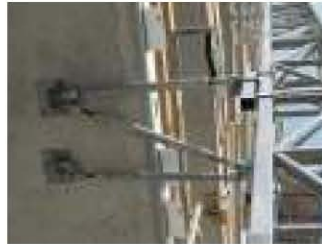
Der Spindelrohranker
