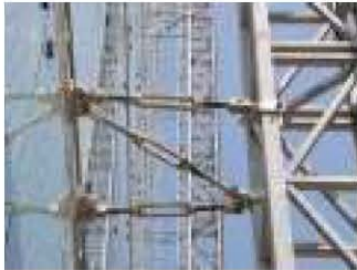
Der Spindelanker
